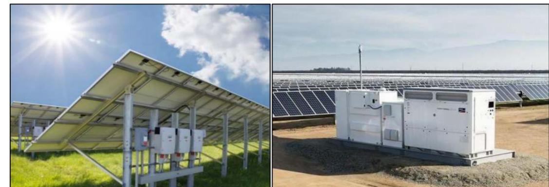
Figure 42 : Comparaison de différents onduleurs : strings ou centralisé
