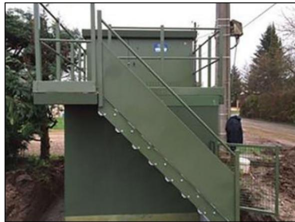
Figure 38 : Exemple de poste de transformation et de livraison HTA/BT réhaussé
